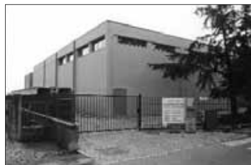
Nella foto la nuova palestra delle Scuole Medie in fase di ultimazione.
